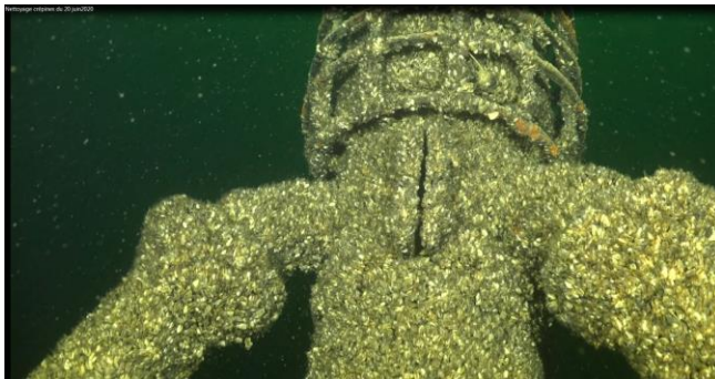
Vue des moules ayant colonisé la crépine – (Prise d'eau dans le lac)
